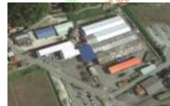
三隅工場 島根県浜田市にある。 オイルシールの量産工場で、 1,500万個/月生産しています。
