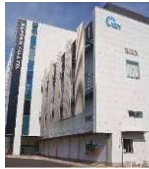
辻堂事業場の再開発を行い、 新しい設計・開発部隊の建屋が 2018年5月に完成しました。
